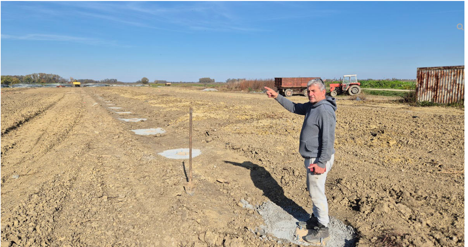
Mirko Bošković pokazuje budući platenik na kojem se grade armirani temelji
