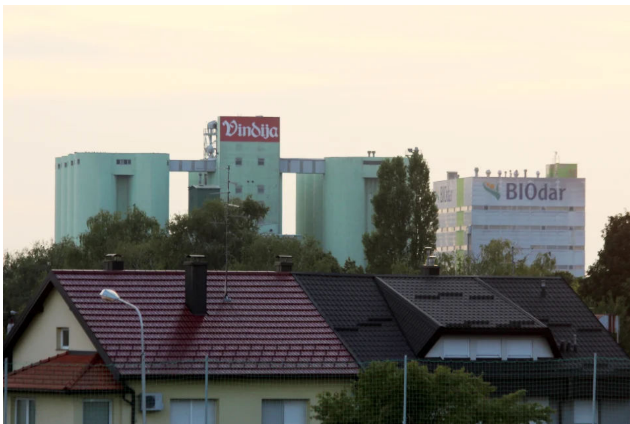
Silos i tvrtke Koka i tvornica stočne hrane Blagodar (Foto: Goran Štimec)
