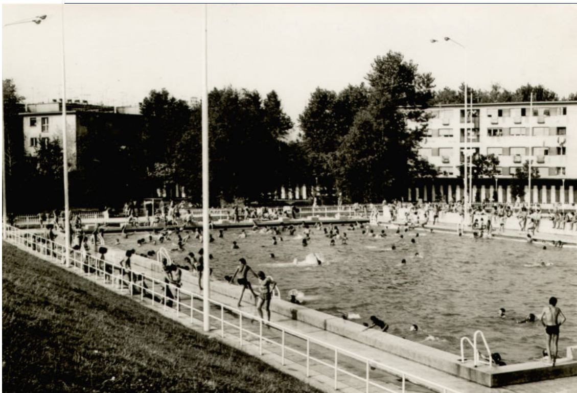
Sisački bazen bio je uništen, ali je ipak obnovljen i vraćen zajednici
