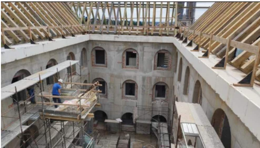
Obnova krovništva i radovi u atriju; foto: Ljetopis Gimnazije Tituša Brezovačkog
