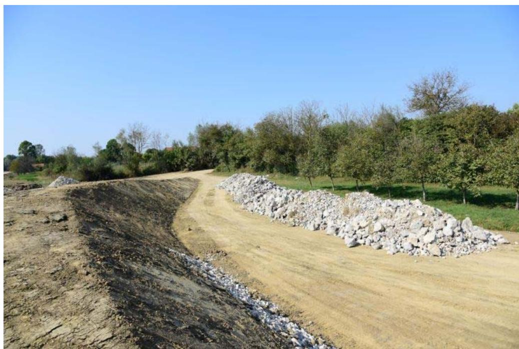
„Nakon početka radova definirana je provedba hitnih 'no regret' mjera povećanja sigurnosti nasipa i zaobilja na dionicama dužine od 172,5 kilometara, izgradnjom 80,2 kilometara balastnih bermi sa servisnim putom i plošnim drenom, 74,8 kilometara servisnih putova s plošnim drenom te osam zasebnih projekata ukupne duljine 17,5 kilometara, izvedbom vodonepropusne zavjese“, navela je dr.sc. Danijela Kosić.
