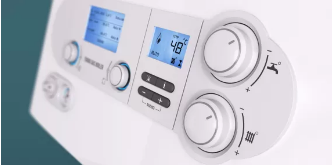
Upravljački dio plinskog kotla (izvornik: Shutterstock)
