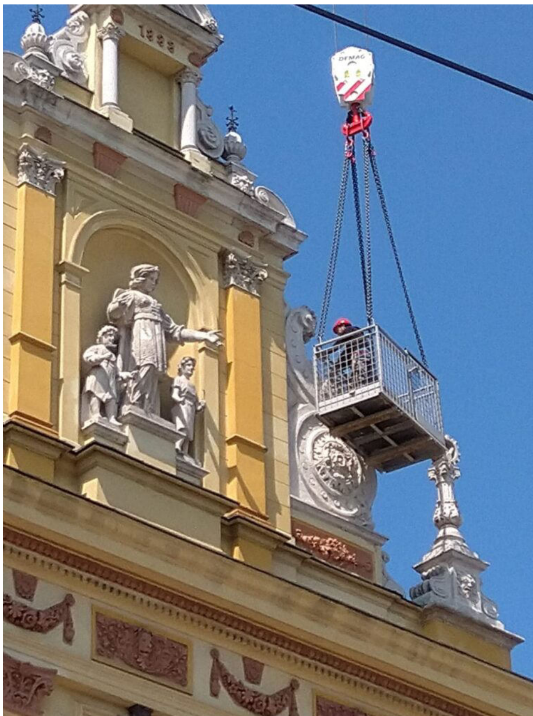
Alegorijska skulptura Dragutina Karla Moraka na vrhu pročelja iznad glavnog ulaza – provjera stanja nakon potresa 2020.; foto: MUO
