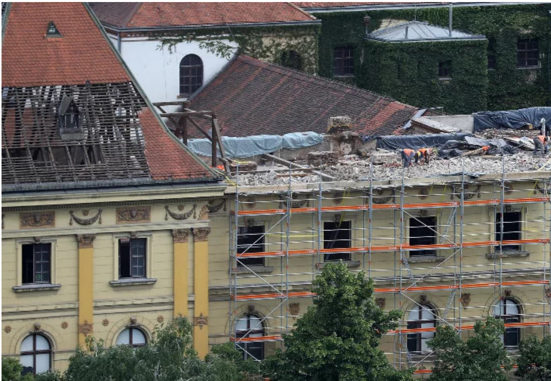
S visine se na Klaićevu srušio krovni vijenac; foto: Lana Silvar Dominić (HINA) i MUO
