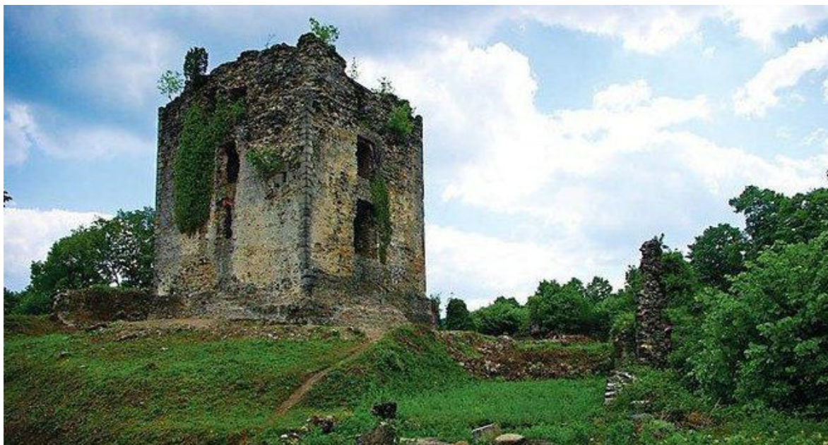
Garić grad prije obnove/Foto: TZ BBŽ
