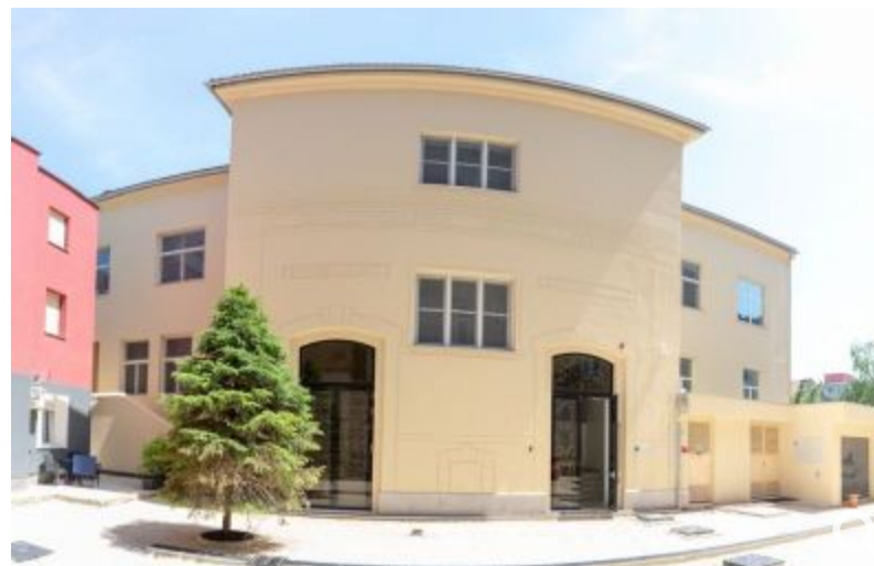
Zgrada Zemaljske uzorite pivnice u Kačićevoj ulici
