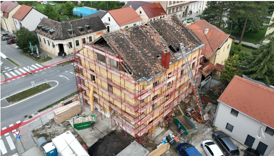
Radovi na tzv. Zgradi braniteljskih udruga u Sisku
