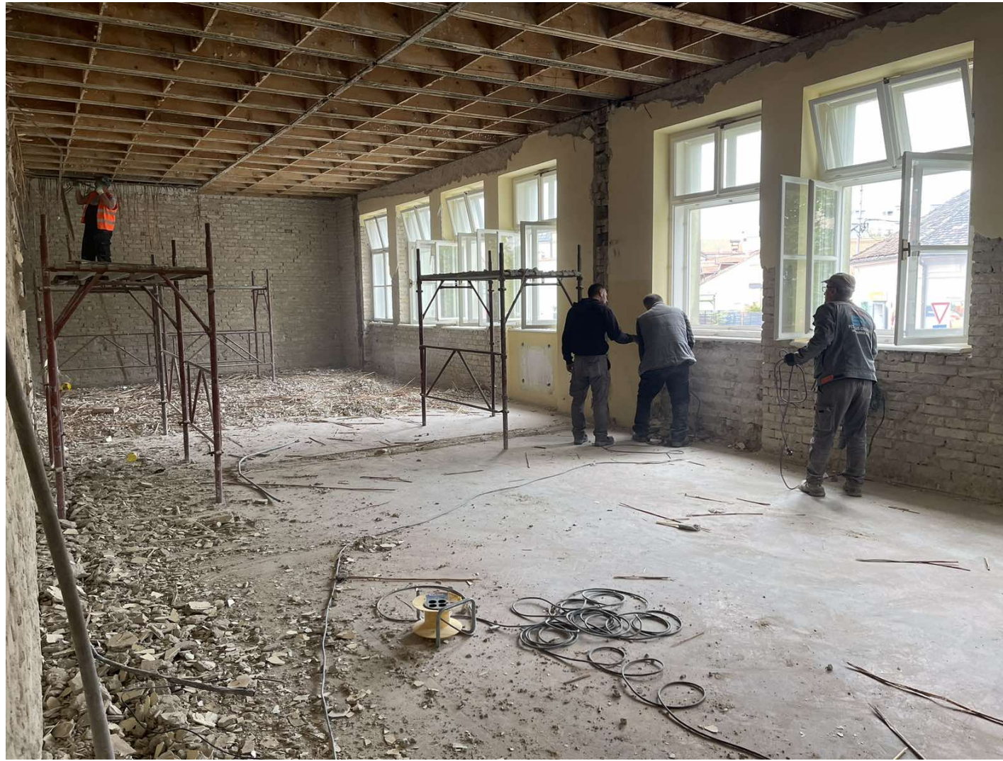
Radovi Gimnazija Sisak
