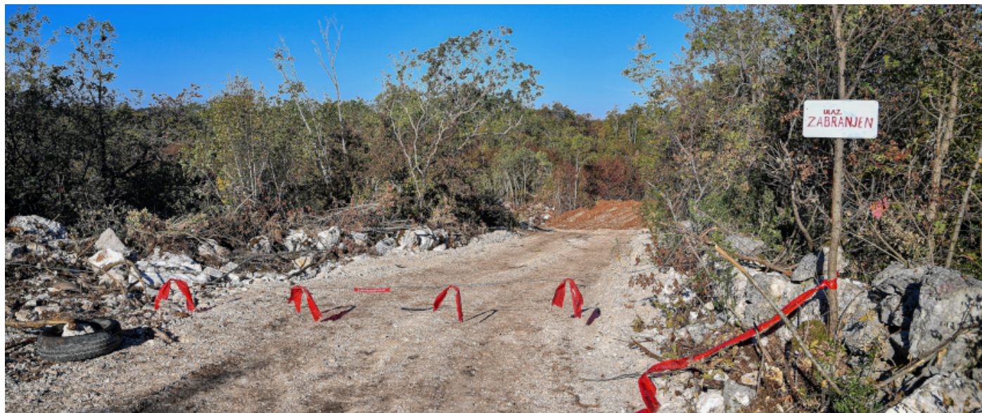
Do budućeg gradilišta već je probijen put. Foto: Tonći Plazibat / CROPIX
