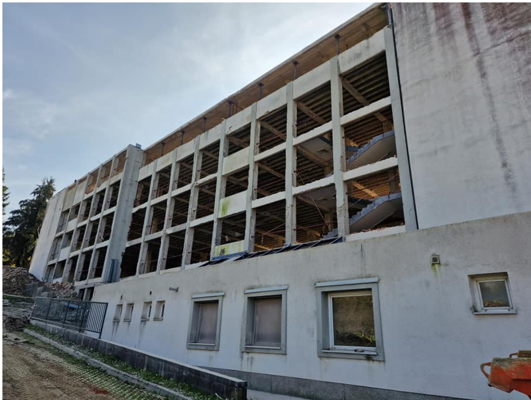
obnova radovi nova bolnica petrinja
