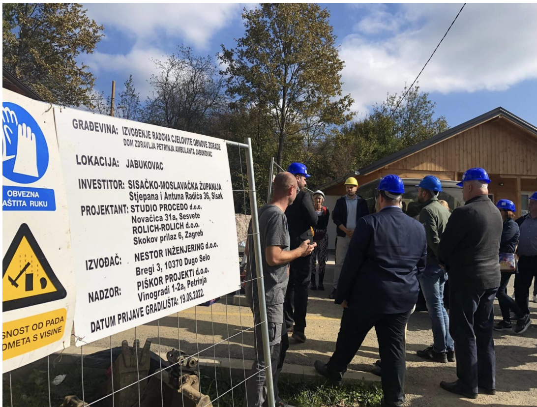
radovi ambulanta Jabukovac
