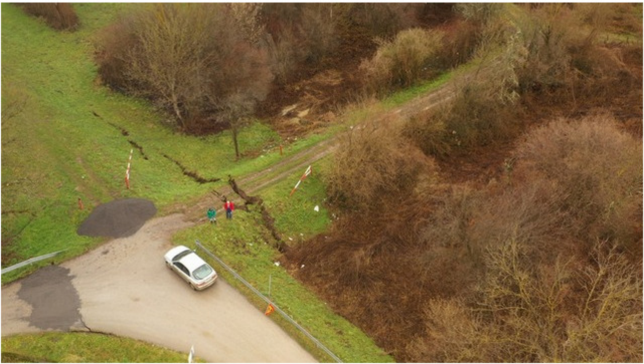
Jedan od slomljenih nasipa za obranu od poplava uslijed petrinjskog potresa (Foto - T. Novosel, Hrvatske vode)
