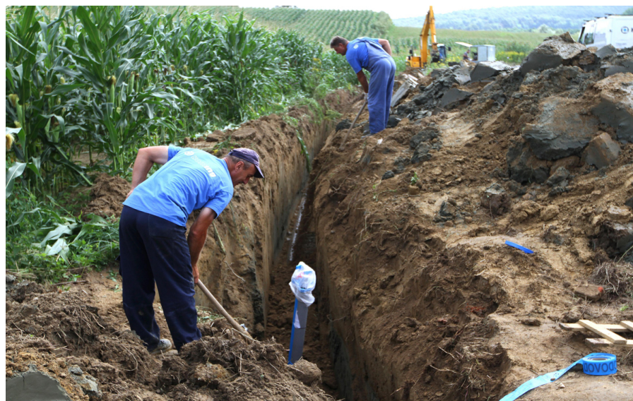
Na području Topuskog već su završeni radovi na izgradnji novih vodovoda (FOTO Marijan Sušenj/PIXSELL)
