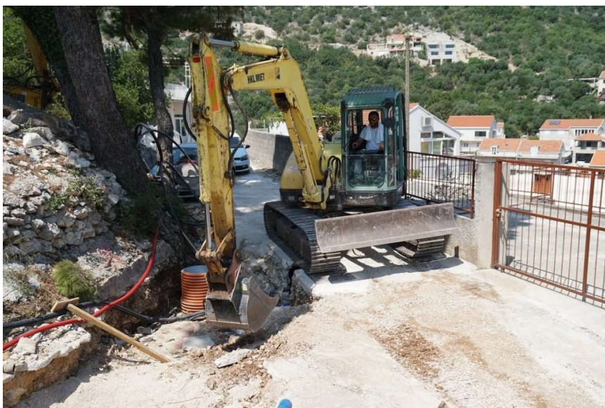
Radovi na infrastrukturi Mokošica (stara)
