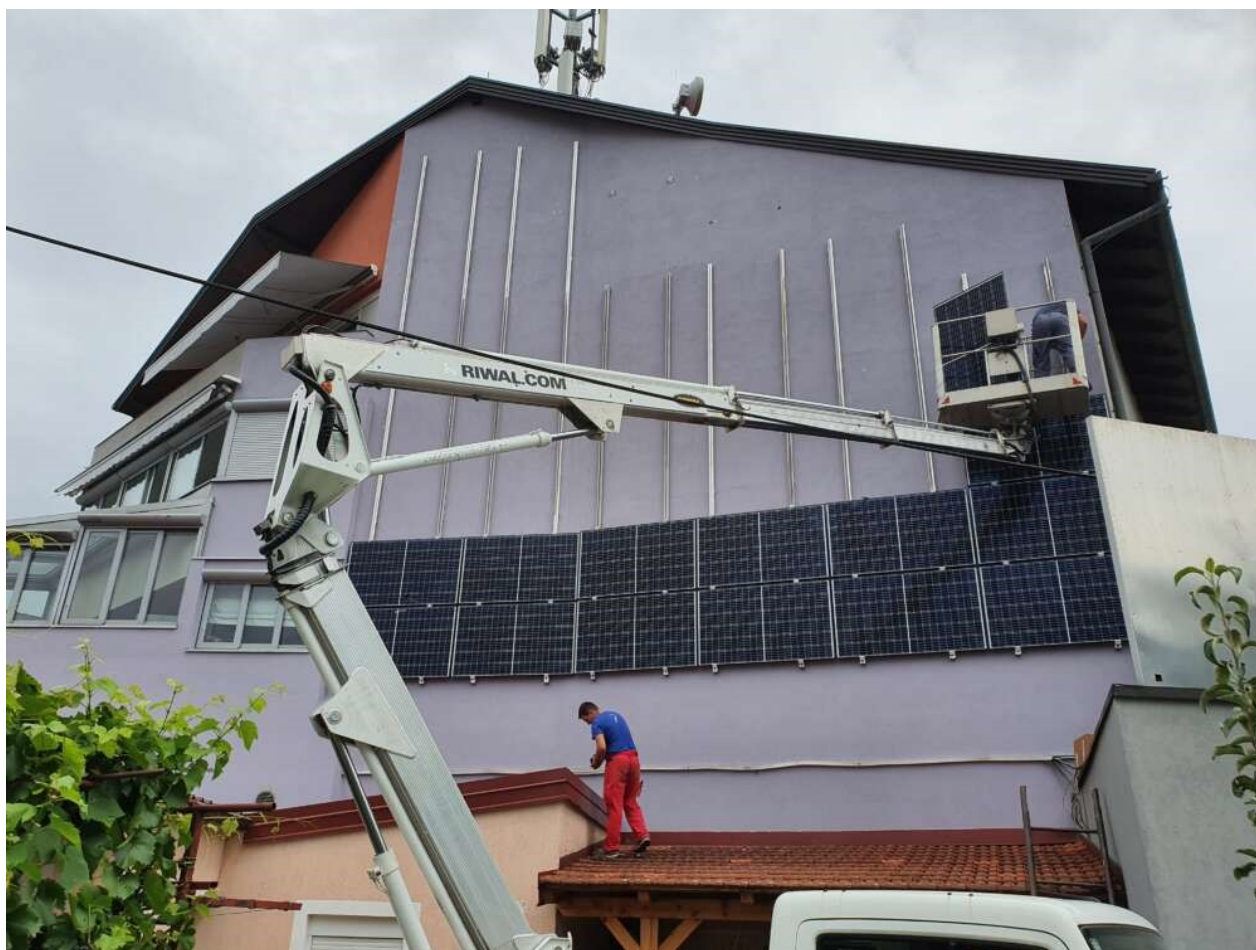
Postavljanje solarne fasade Foto: Lj. Majdančić
